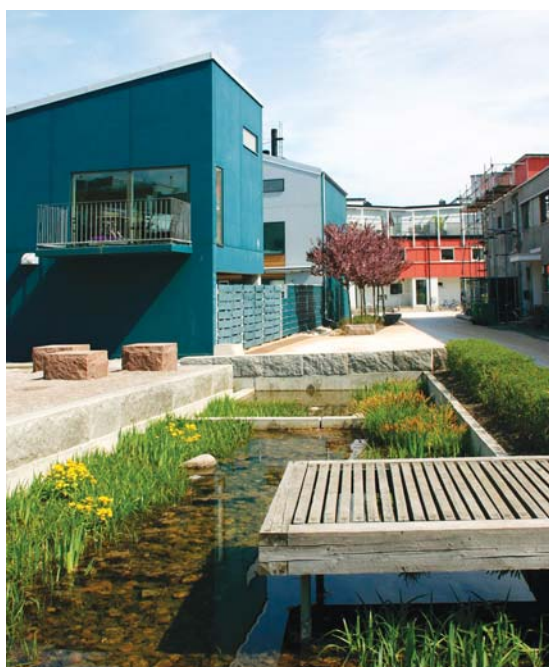
Bo01的徑流處理系統結合水塘和生態棲息地設計
